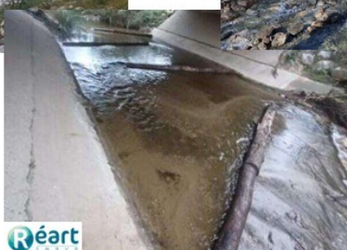
Radier du pont de la RD 42 à St Nazaire / Saleilles
