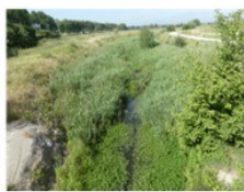
-1- Zone amont Recalibrée, Re-végétalisations facilitée par un substrat plus naturel
