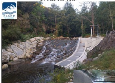
Prise d'eau pour l'eau potable sur le Riuferrer à Arles-sur-Tech
