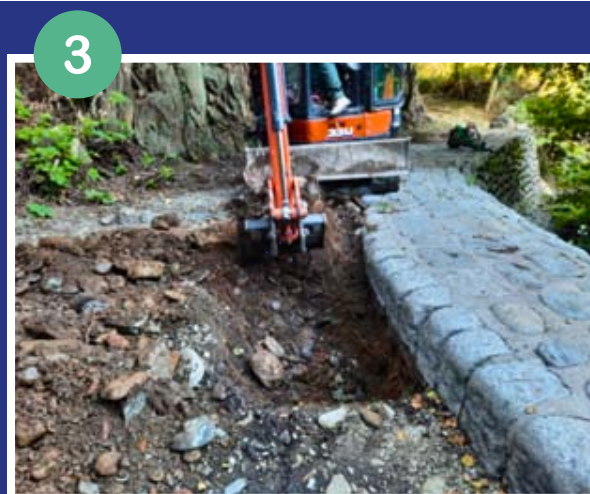
3 Sondage à la pelle mécanique pour étudier la nature des sédiments piégés par le seuil
