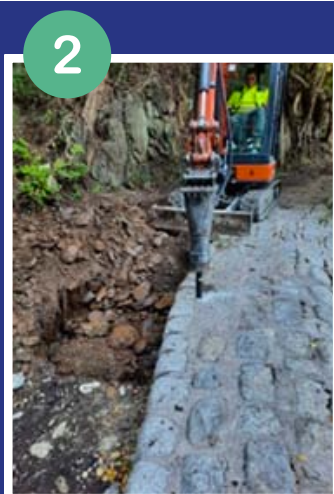
2 Etude de la structure de l'ouvrage par sondage
