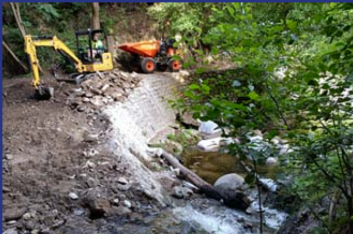
Démolition du Seuil
